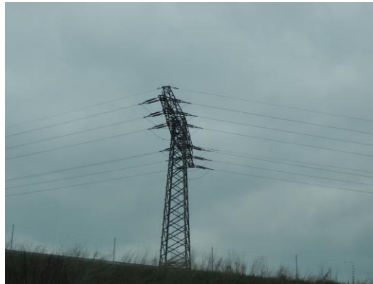
Obrázek 27 - rovinné uspořádání vodičů
