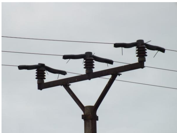
Obrázek 34 - Klobouková zábrana na vodorovné konzoly
