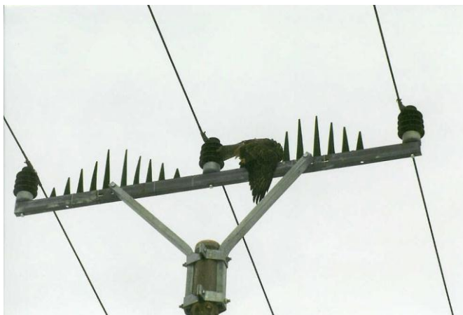
Obrázek 33 - dravec usmrcený na hřebenové zábraně
