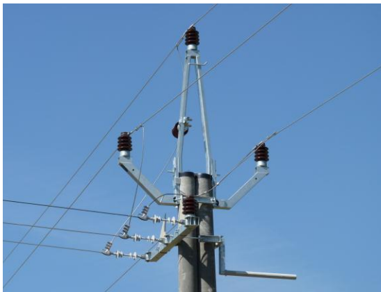
Obrázek 17 - Konzola pařát III s odbočením
