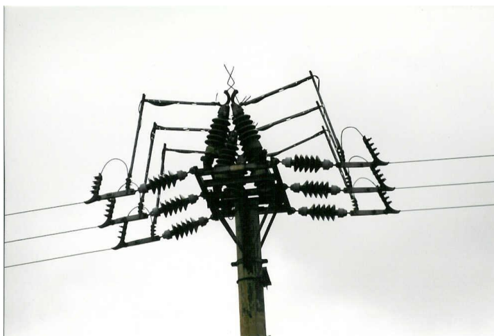
Obrázek 39 - Úsekový spínač v provedení do vedení
