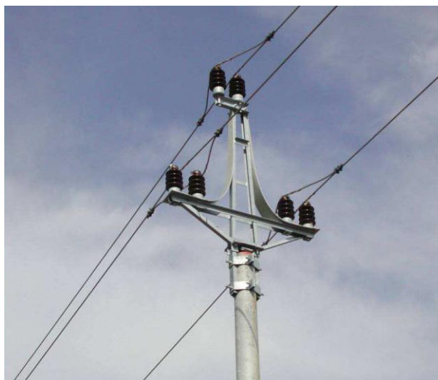
Obrázek 5 - Konzole Delta s plastovými pásky
