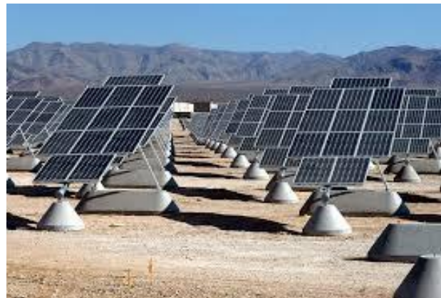
Obr. 11 - Polární jednoosý sledovač [20]
