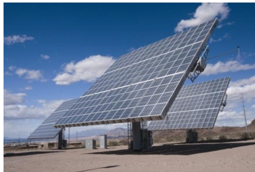
Obr. 17 - Fotovoltaický panel s koncentrátorem z Fresnelových čoček [34]
