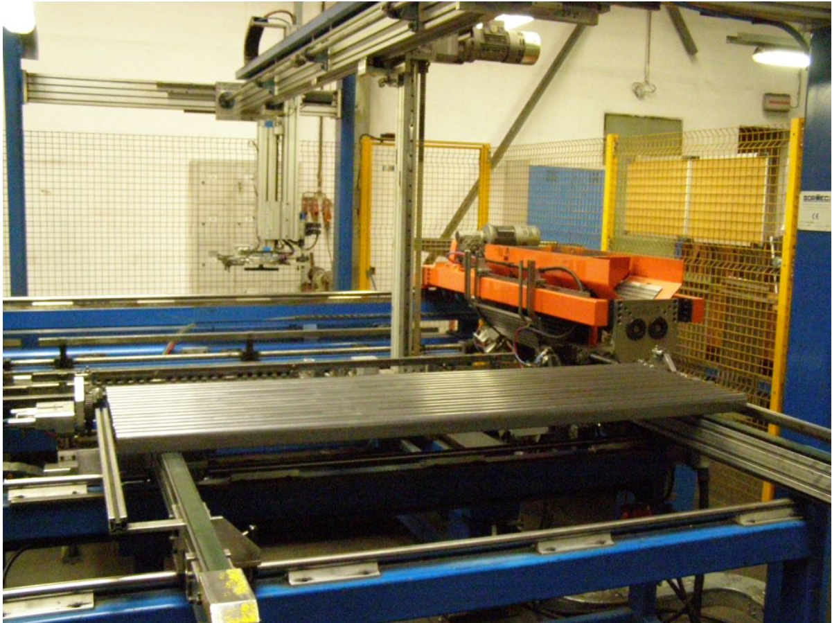
Obrázek 19: Trapézy připravené na sesazení v zásobníku automatu D123
