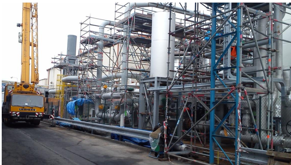
Obr.21 Ukázka průběhu stavby
