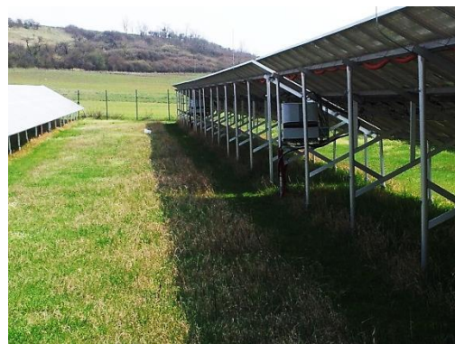
Obr. p.9 Pohled na FV panely SST 240-60M
