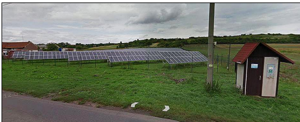
Obr. 3.1 Pohled na FV elektrárnu Tuhaň
