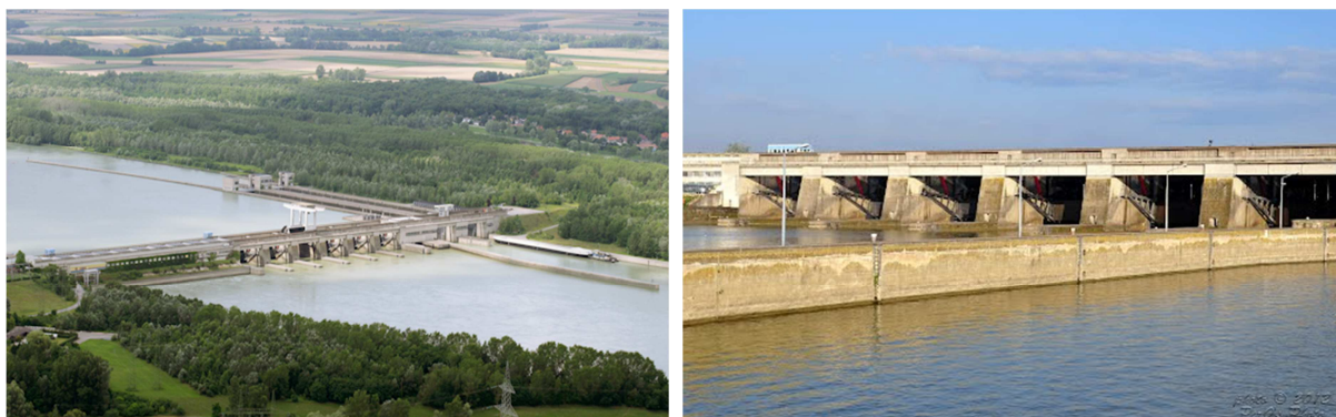
Obr. 58 Kraftwerk Altenwörth – Rakousko. Převzato z [61] [62]
