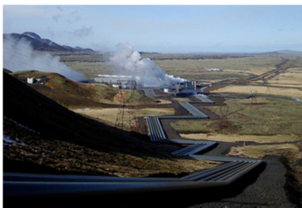
Obr. 64 Nejvíce geotermálních elektráren funguje v Itálii. Převzato z [75]
