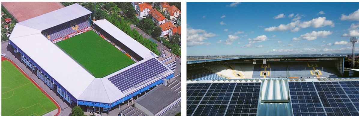
Obr. 53 Fotovoltaická instalace na fotbalovém stadionu v Německu. Převzato z [7]
