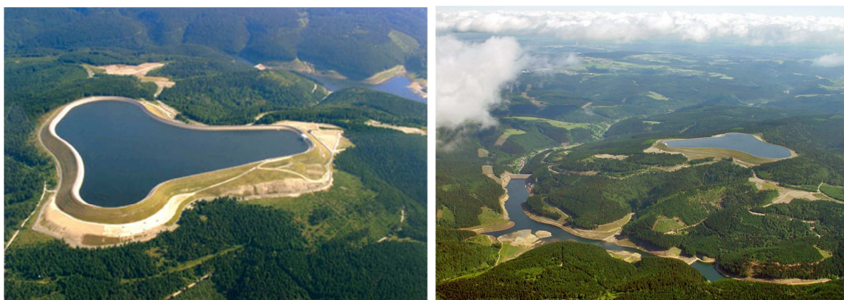
Obr. 62 Přečerpávací elektrárna Goldisthal. Převzato z [68] [69]
