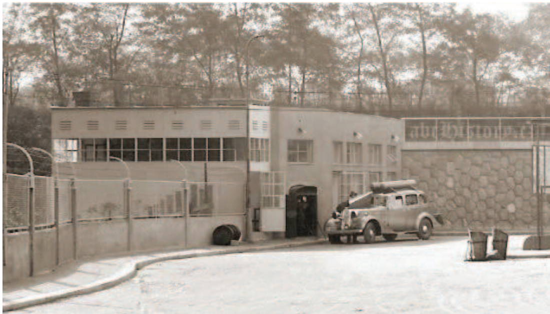
Obrázek 4:Plnicí stanice v areálu pražské plynárny v Michli [11]
