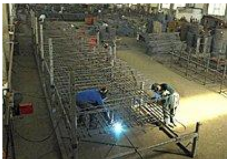
Obrázek 13: Sváření armovacího koše v armovně společnosti Arma Bau
