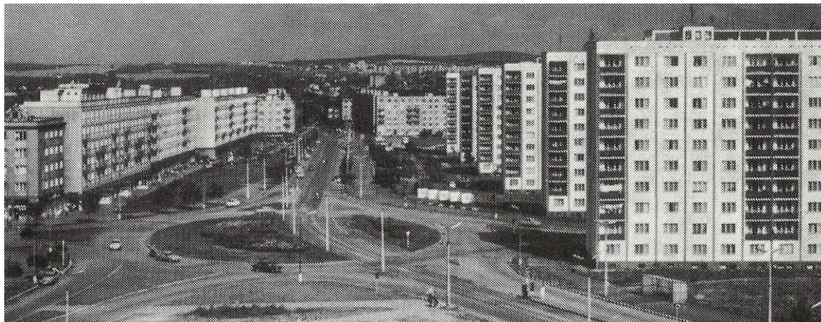
Pohled na náměstí J. Krautwurma od jihu – Slovany IV. s bytovými domy T02B (vlevo) a ATYP (vpravo)
