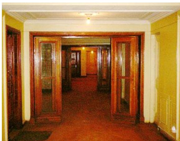
Рисунок 50. В холле 14-го этажа бокового корпуса потолок на полметра ниже, чем на других этажах
