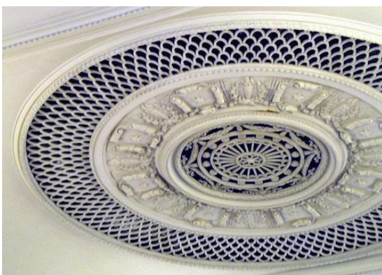
Рисунок 27. Наружная вентиляционная решетка в актовом зале ГЗ МГУ
