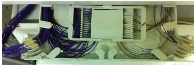
Obrázek 2.13 Kazeta pro uložení svařených vláken
