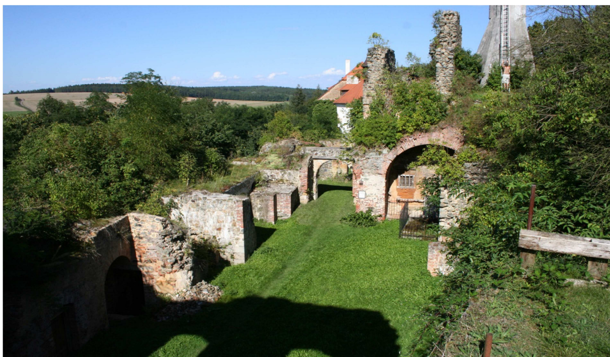
Příloha č. 14: Dnešní pohled na nádvoří. Foto autor, 24. 9. 2012.
