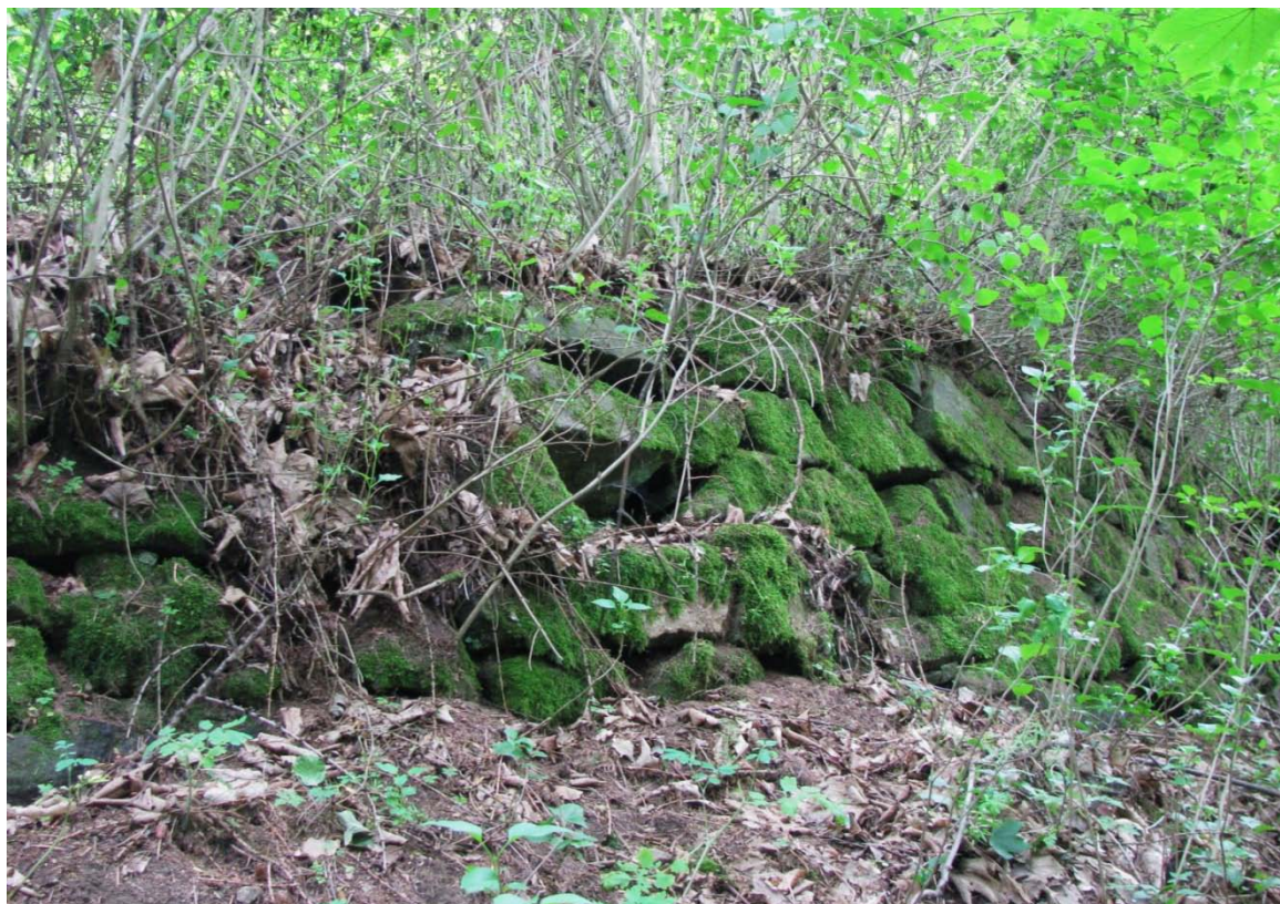
4. Dochované zbytky obvodového zdiva prostoru bývalé šibenice (2013)
