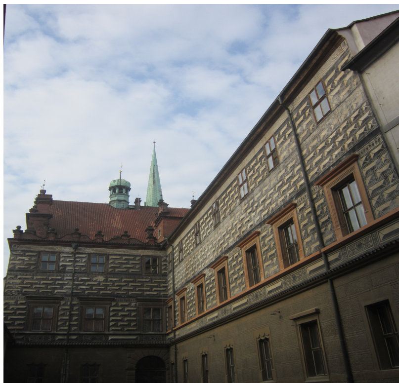
Obrázek č.16 zadní část radničního komplexu
