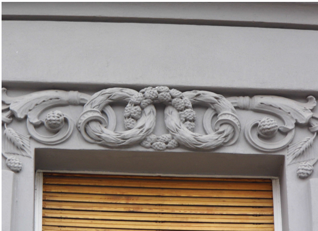
obr.25 Štuková výzdoba s chmelovým motivem na budově Komerční banky 1
