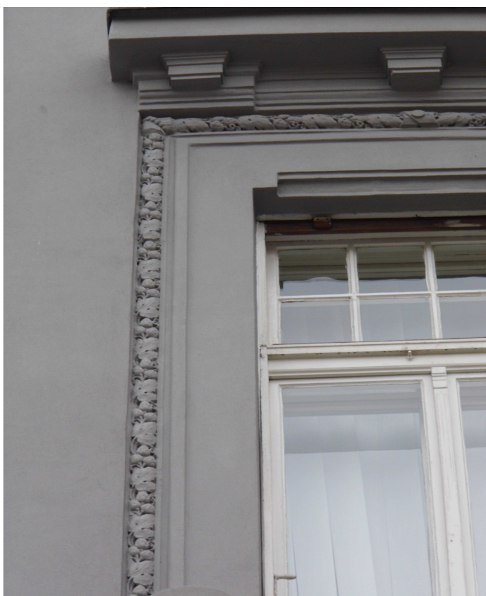
obr.26 Štuková výzdoba s chmelovým motivem na budově Komerční banky 2
