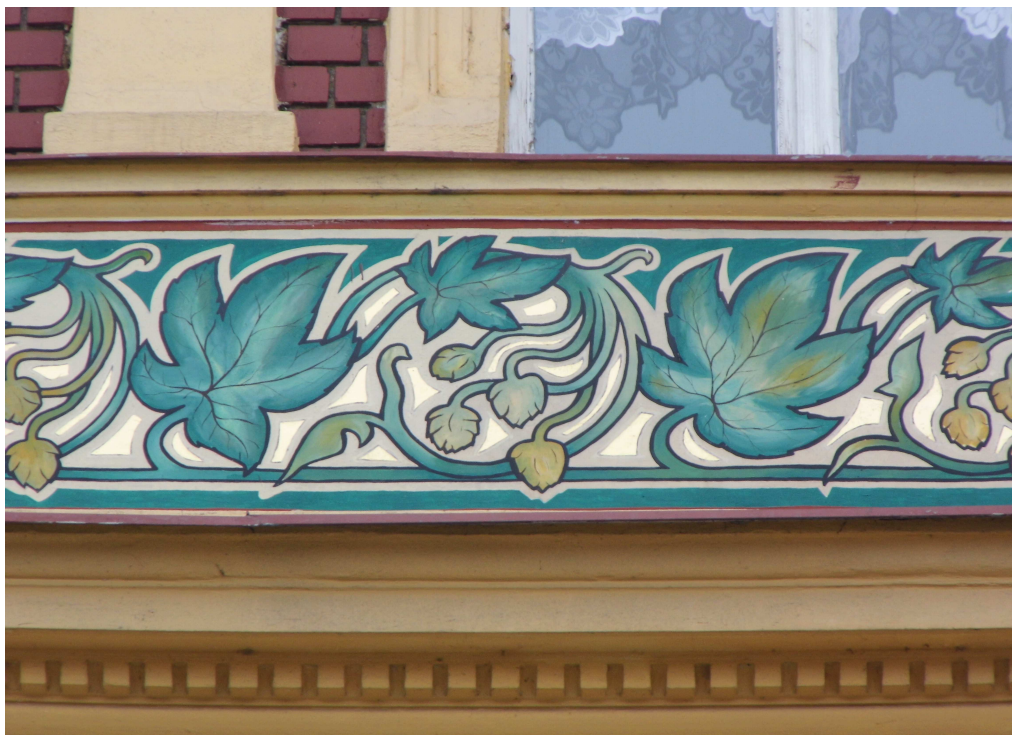
obr.30 Malovaná lišta domu na třídě Obránců míru
