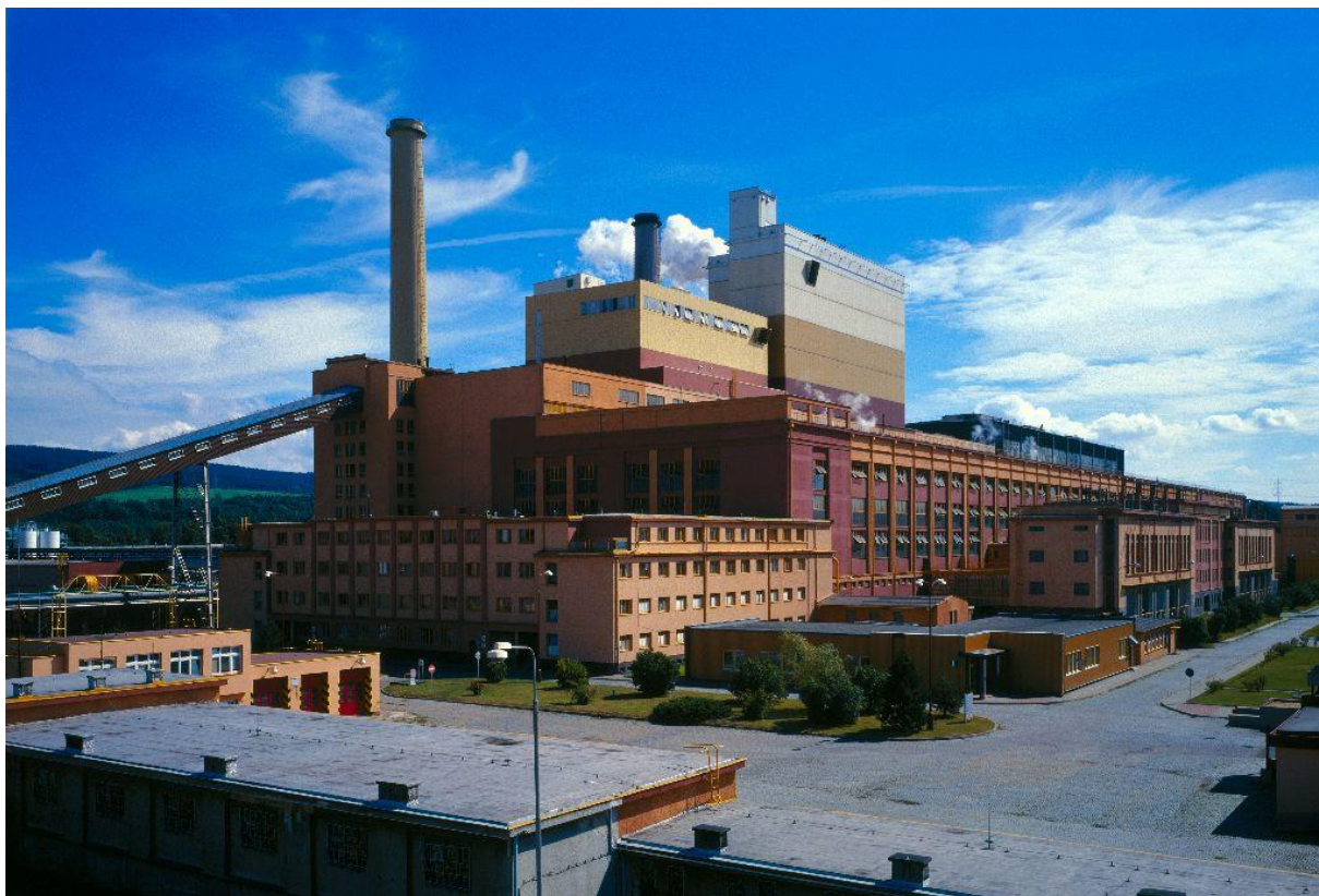
Obr. č. 3: ČEZ a.s., OJ elektrárna Tisová – celkový pohled, zdroj [11].
