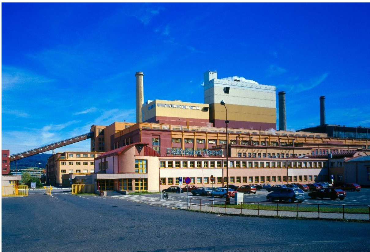
Obr. č. 4: ČEZ a.s., OJ elektrárna Tisová – hlavní brána a vrátnice podniku, zdroj [11].
