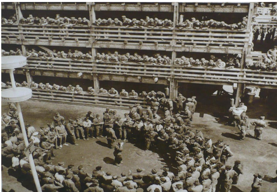
Obr. 1: Pohled na dřevěné šatny.
