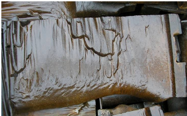
Obr. 4.7 Opatřebení desky uhelného mlýnu z oceli 42 2921 po půl roce provozu
