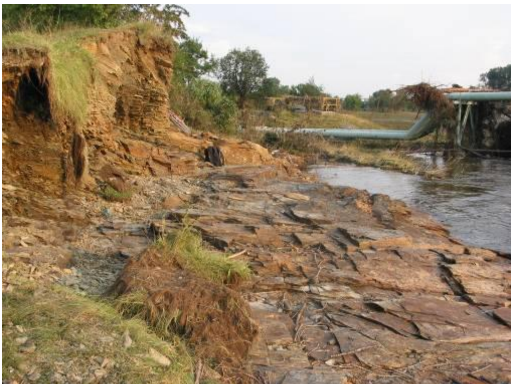
Příloha č. 14, Erozí deformovaný břeh u bývalé lávky v Lobzích, jejíž nízké a úzké rozměry způsobily při povodni turbulentní proudění s ničivými účinky, fotografie: P. Mentlík
