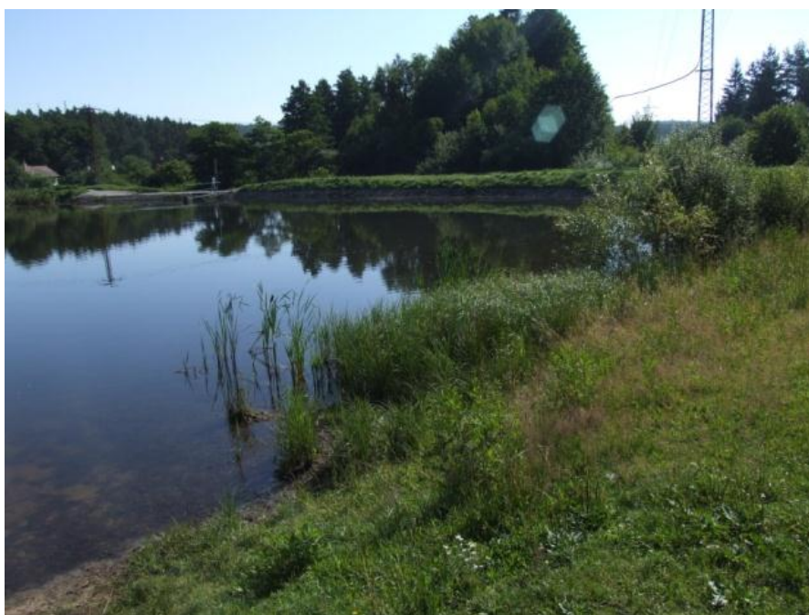
Obrázek 4 - Lokalita 2, západní pohled na hráz (zdroj: vlastní)
