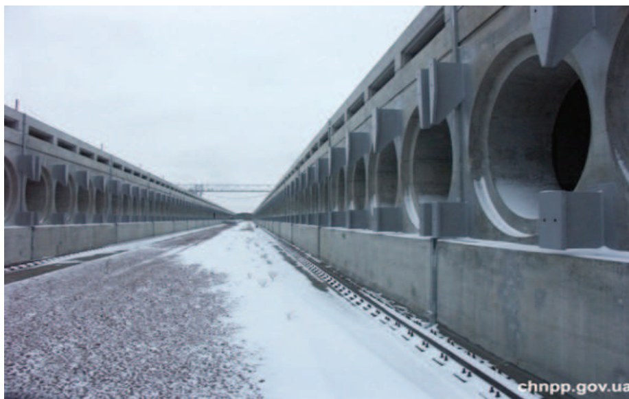
Obr.: 5 – Horizontální modulový sklad (Černobyl – Ukrajina) [6]
