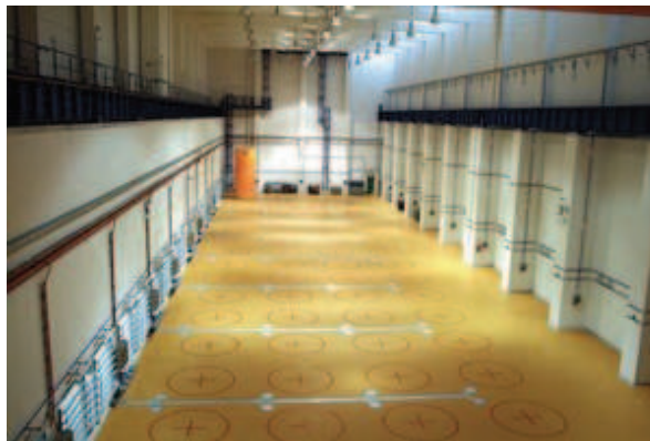
Obr.: 11 – Mezisklad zevnitř - ETE [8]
