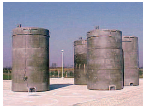
Obr.: 7 - Betonové boxy [7]
