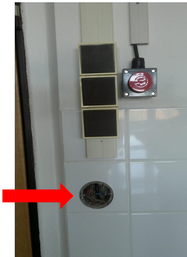
Obrázek 2.8: Nezakrytý otvor
