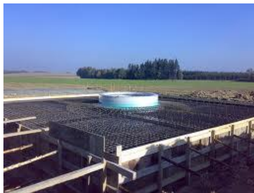
Obr. 2.1.1 – Betonový základ VE [7]
