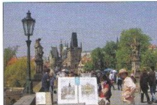
Karlův most – Staroměstská mostecká věž
