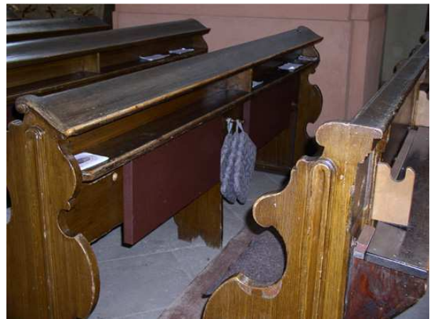
Obr. 2.1-3 Využití sálavých panelů
