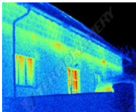
Obr. 34 Tepelné úniky na objektu [22]
