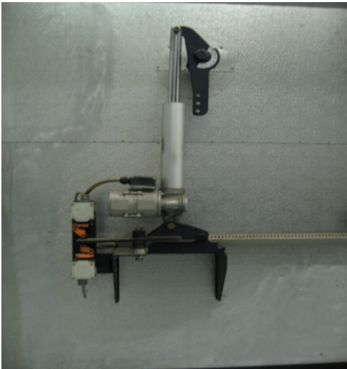
Obr. 22 Uzavírací klapka se servomotorem
