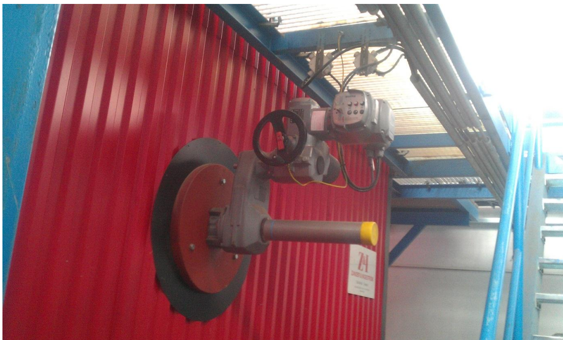
Obr. č.3 – motor pro řízení stínění elektrokotle
