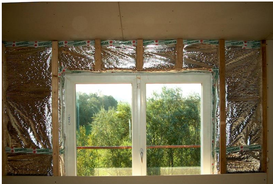
Obr. 3.5 Ilustrace příček ve vzduchové mezeře [5]
