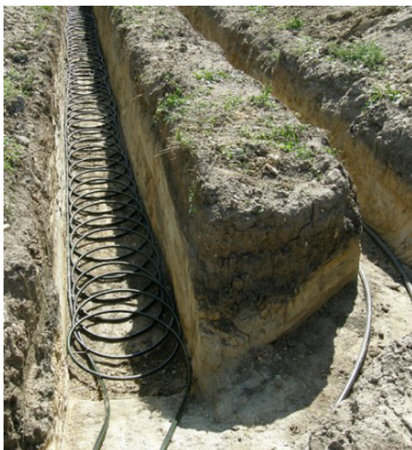
Obr. 4.5 Plošný kolektor ( http://www.tepelnecerpadla.eu.sk )
