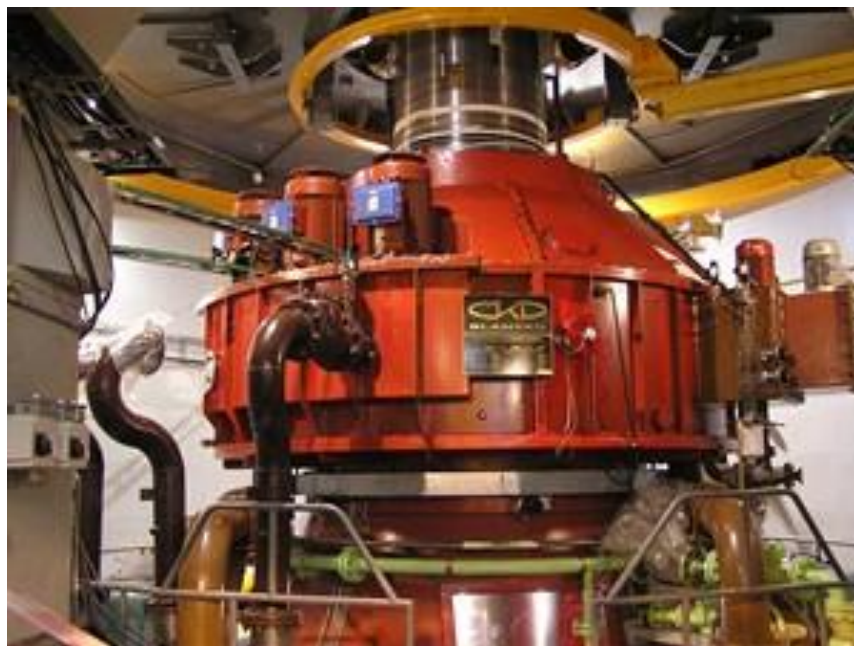
Obr. 36 Motor - generátor PVE Dlouhé Stráně (ČKD Blansko), převzato z [25].
