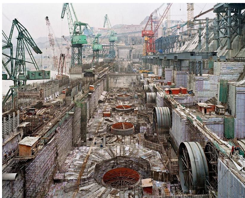
Obr. 38 Stavba vodní elektrárny Tři soutěsky v Číně, převzato z [47].
