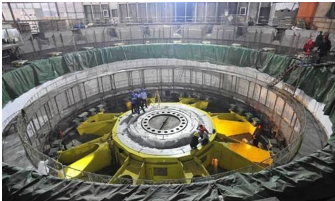
Obr. 39 Jeden z 32 hlavních hydroalternátorů v elektrárně Tři soutěsky v Číně, převzato z [28].
