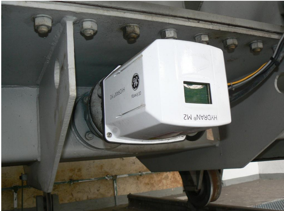
Obr. 2.9 Umístění Hydranu M2 na 65BCT53 na dolní části nádoby
