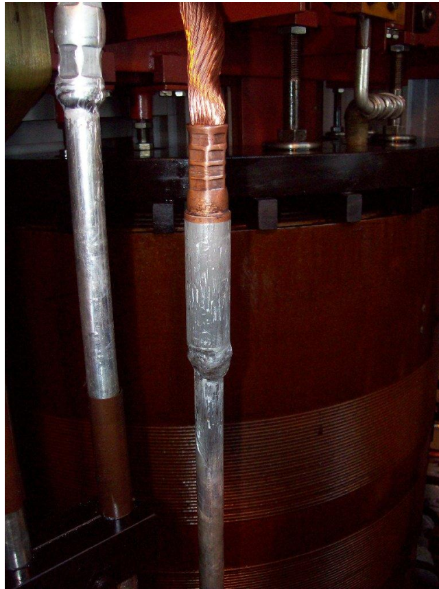
Obr. 2.19 Místo poruchy po opravě (převzato z [21])
