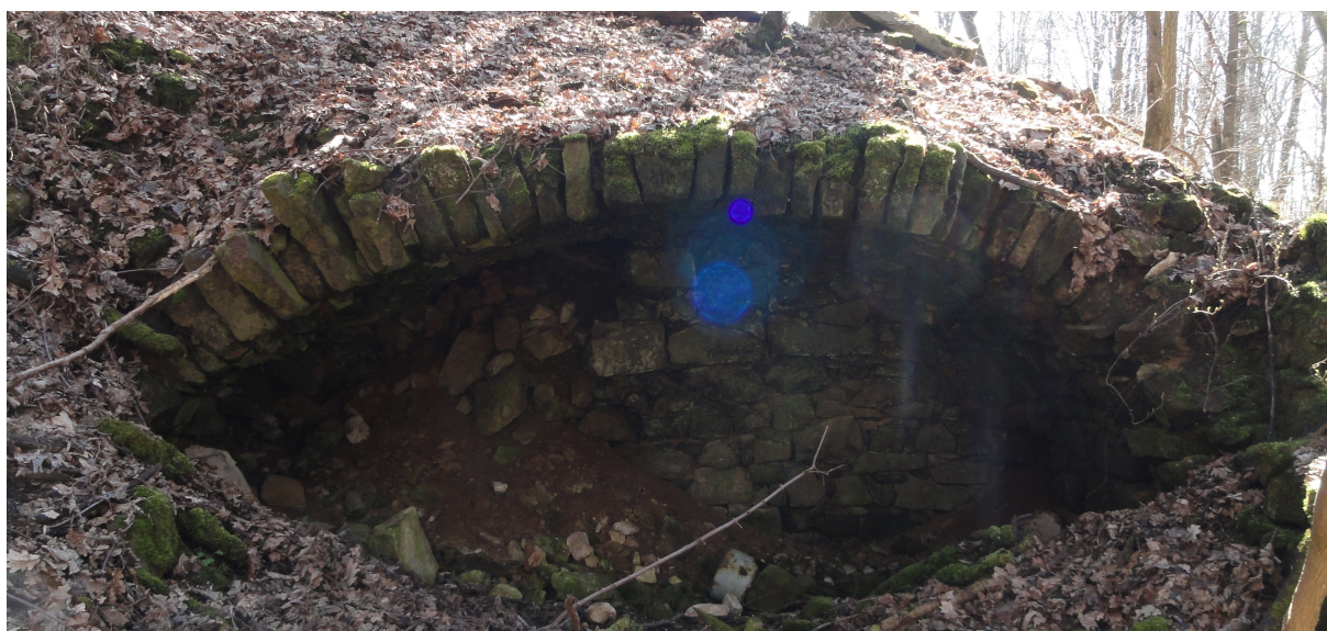
Obr. 33. Zbytky valeně klenutého zámeckého sklepa (foto autor, 2012).
