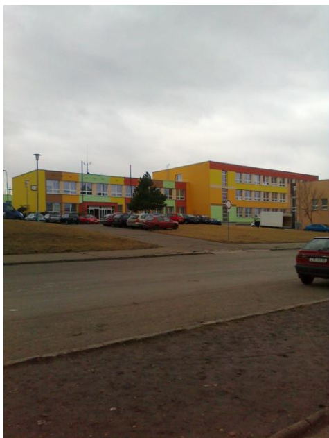
Budova chanovské základní školy
