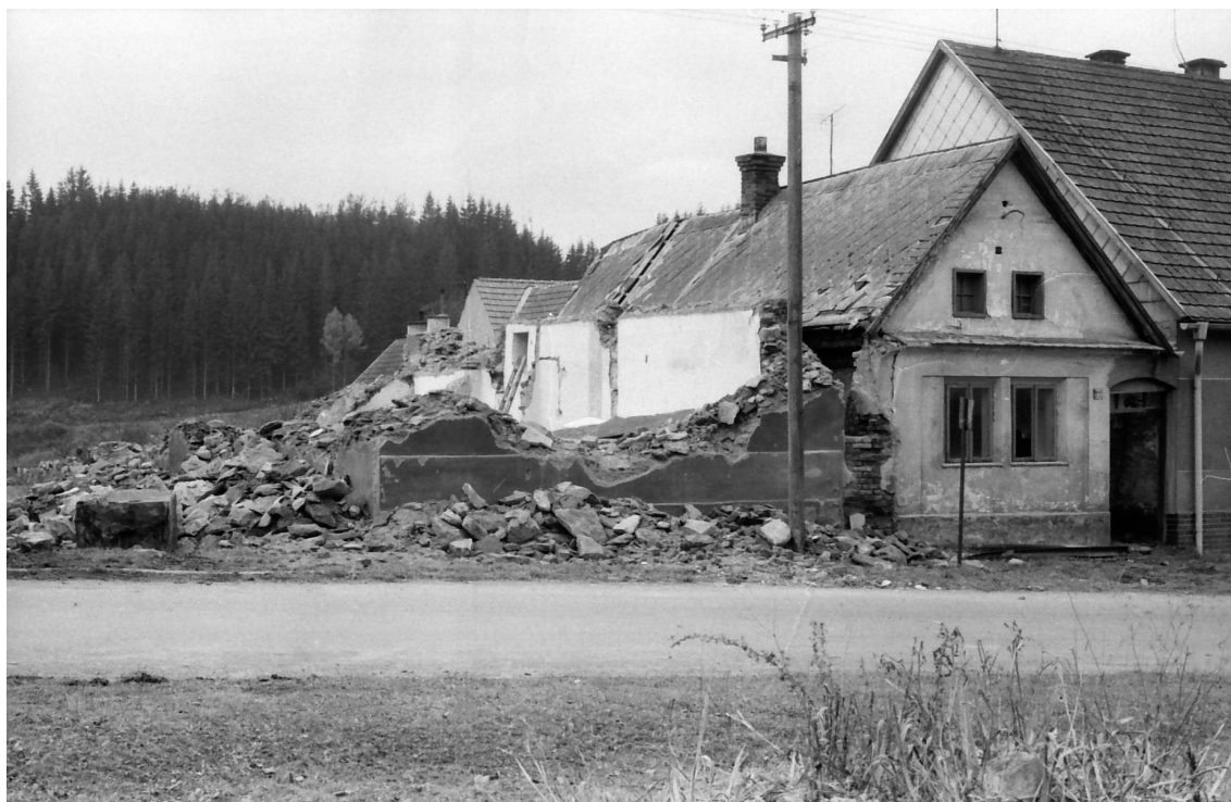
Obr. 24: Postupná demolice Zahradčických domů (1973–1975).
