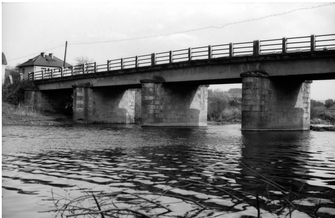
Obr. 15: Most přes řeku Želivku (1973–1975).
