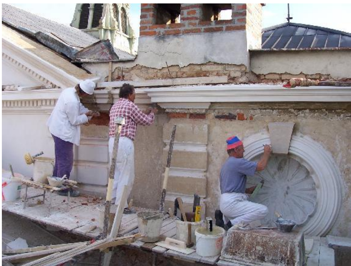
Obr. č. 14: Průběh štukatérských prací během rekonstrukce sokolovny
