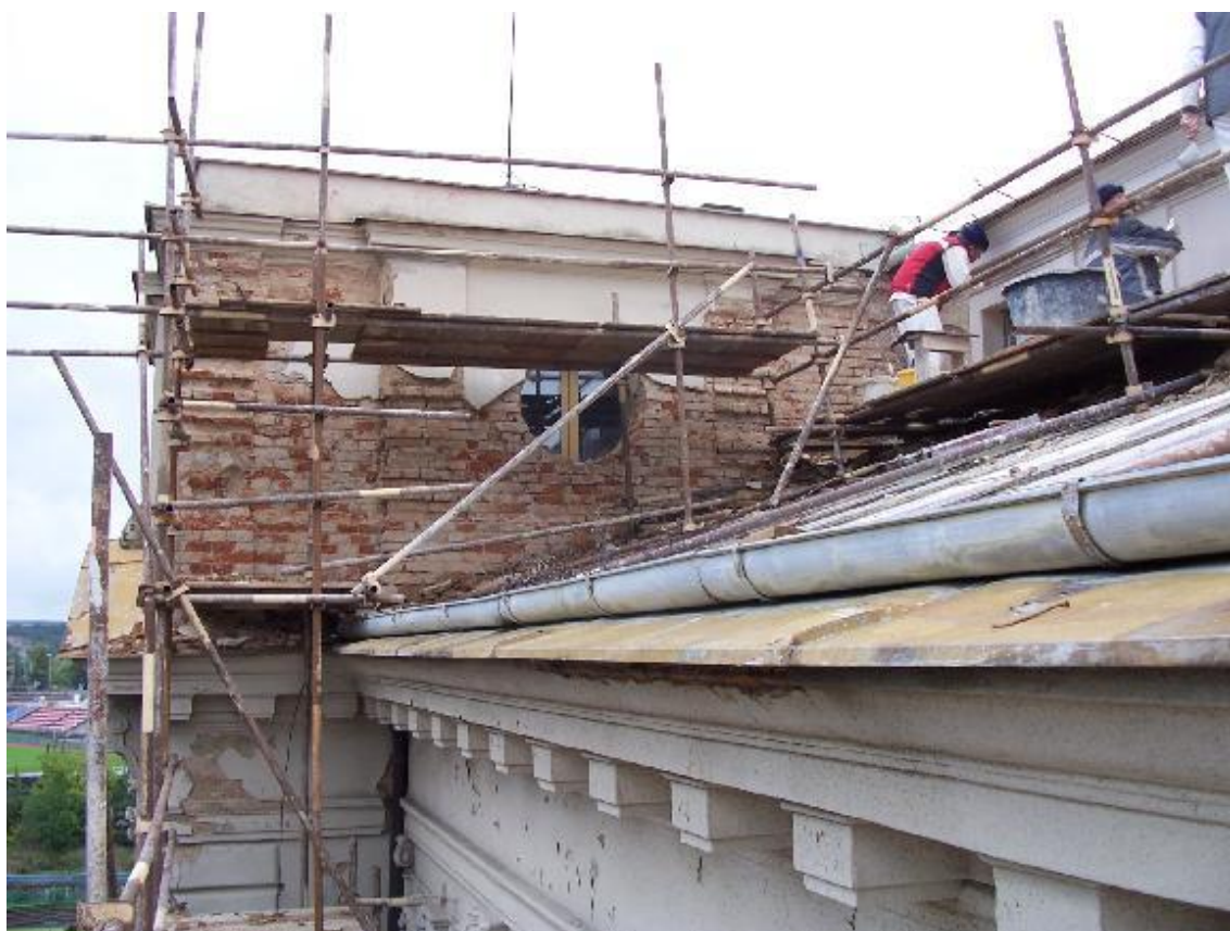
Obr. č. 13: Zahájení stavebních prací na objektu plzeňského Sokola
