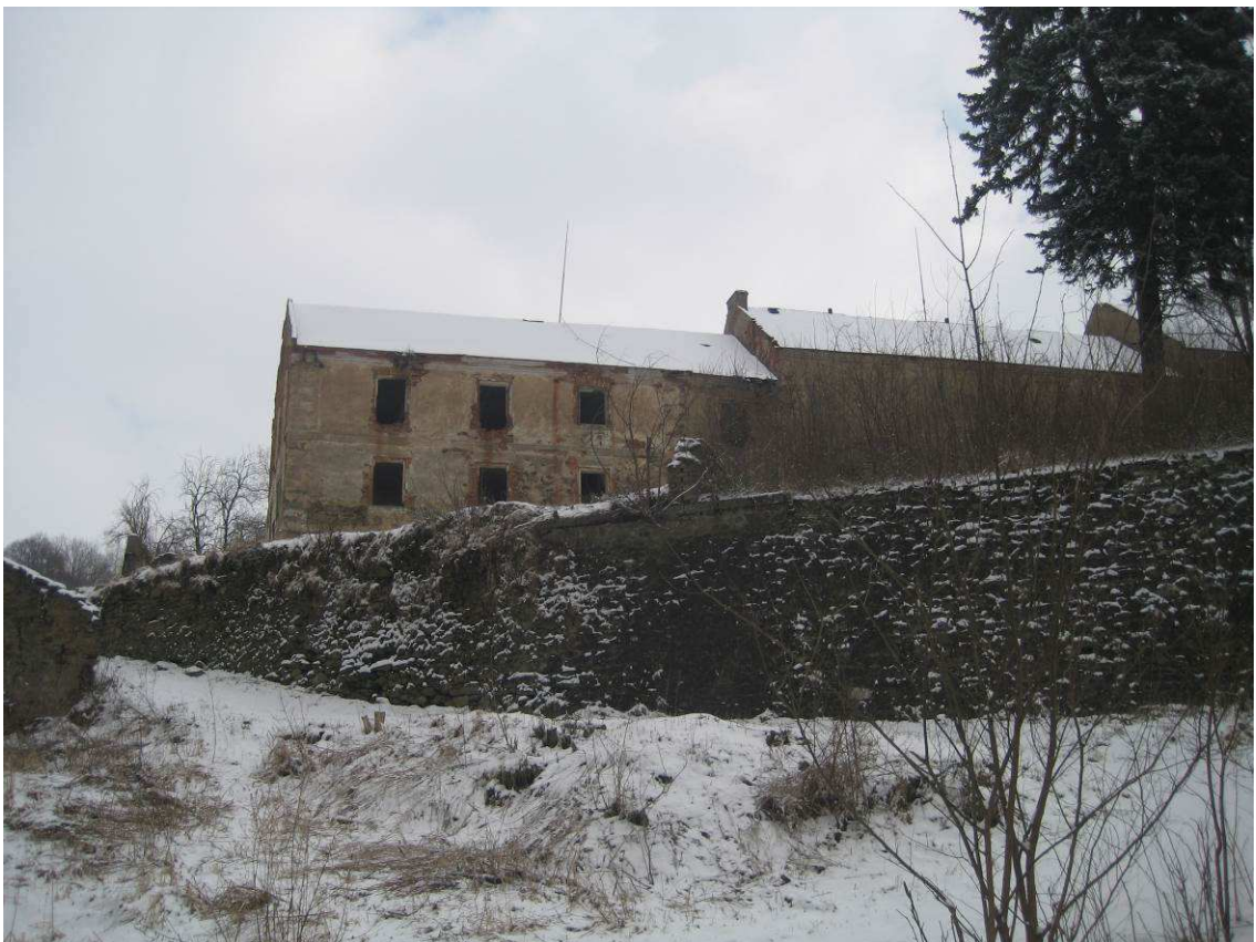
Obr. 23. Budova bývalého hostince ve vsi Skoky. (Foto autor)
