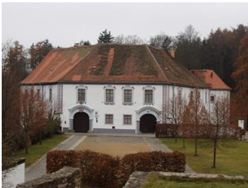
Obr. 21 Zámek Chanovice – pohled z východní strany (foto: autorka, 2012)
