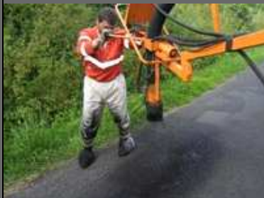
Vysprávký vozovek tryskovou metodou
