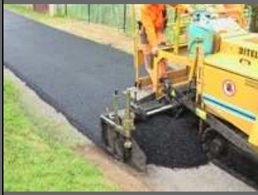
Zhotovení nové povrchové vrstvy místních komunikací
