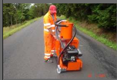
Sanace spár a trhlin
